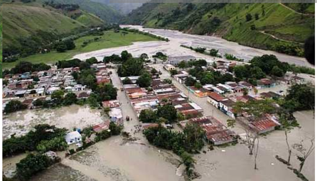
Cauce desbordado del Río Boconó, Trujillo – Venezuela.
